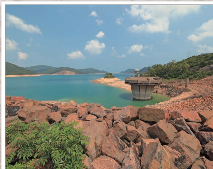
1 鐘形虹吸溢洪道 Bellmouth Siphon Spillway
